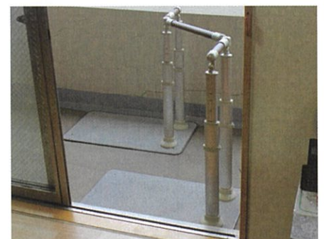
設置商品 AT-C-630 築14年のマンション。 ベランダと室内に5cmの段差があり、出入り補助として設置。
