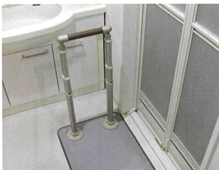
設置商品 AT-C-240 築14年のマンション。 洗面所での立位補助として使用。
