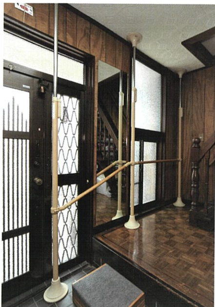
玄関 (H型手すり)
