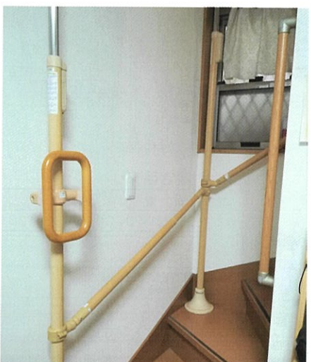
階段 (H型手すり+角型手すり)
