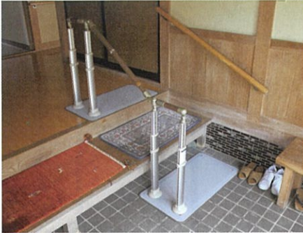
設置商品 AT-C-930 建替後40年超の戸建。 2段かまちに設置。 壁付け手すりと併せて使用。
