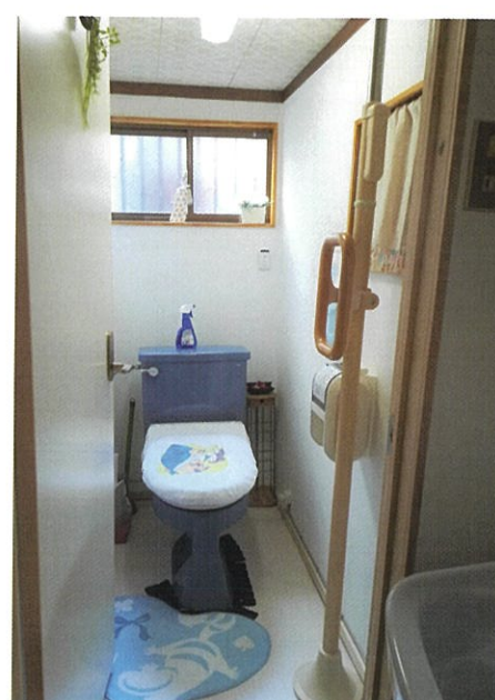
トイレ (角型手すり)
