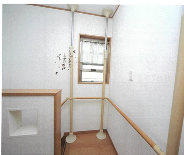
廊下 (H型手すり)
