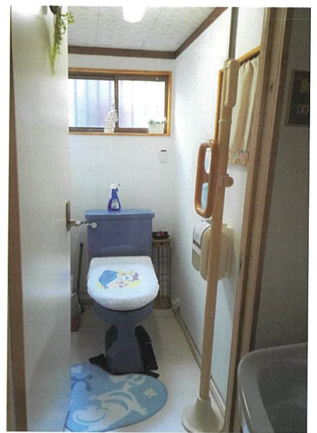
トイレ (角型手すり)
