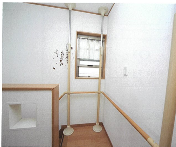
廊下 (H型手すり)
