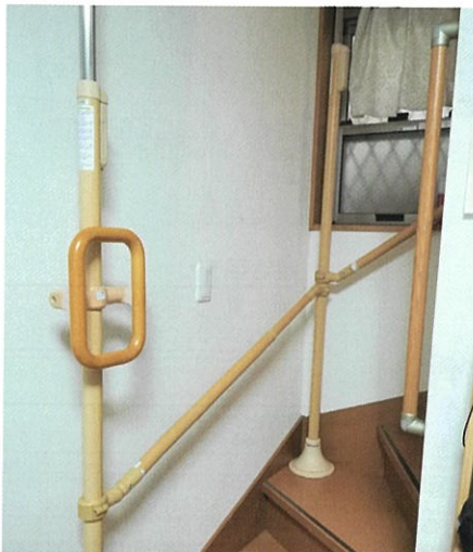
階段 (H型手すり+角型手すり)
