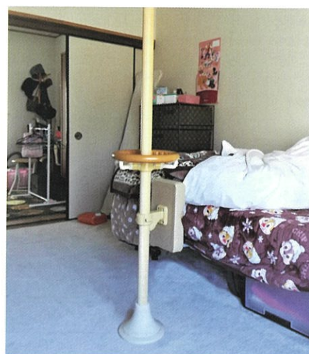
居室 (円型手すり+膝当て手すり)
