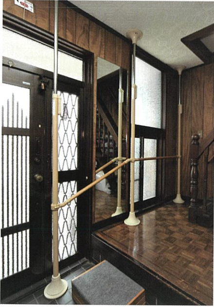
玄関 (H型手すり)
