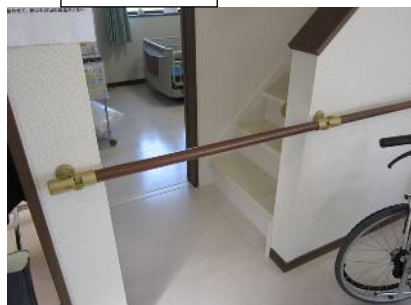
通路には取り外しが できる手すりを施工
